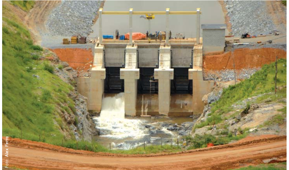
Construção da Pequena Central Hidrelétrica (PCH), Santa Fé
