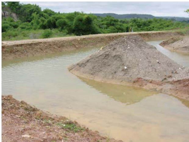
Figura 1 – Armazenamento temporário dos cascalhos de perfuração do Campo de Carmópolis
